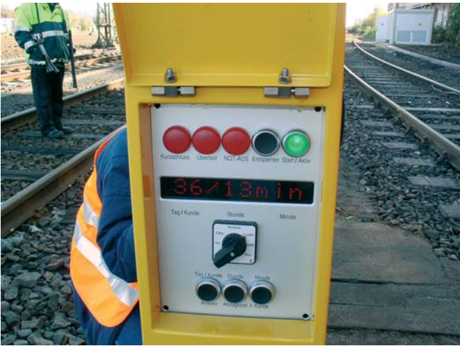
Abbildung 2: Bedieneinrichtung in einer neuen Steuersäule.
