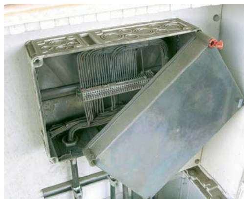
Abbildungen 1 bis 3, von links nach rechts. Abbildung 1, Seite 4: Neue Unterstation. Abbildung 2: Spannungsversorgung und Erdschlussüberwachung. Abbildung 3: Klemmkasten zum Anschluss der Kabel.
