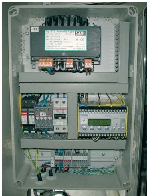
Abbildungen 1 bis 3, von links nach rechts. Abbildung 1, Seite 4: Neue Unterstation. Abbildung 2: Spannungsversorgung und Erdschlussüberwachung. Abbildung 3: Klemmkasten zum Anschluss der Kabel.
