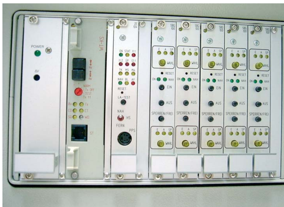
Abbildung 5: Ortssteuerung mit Drucktasten auf den Mastschalterkarten.
